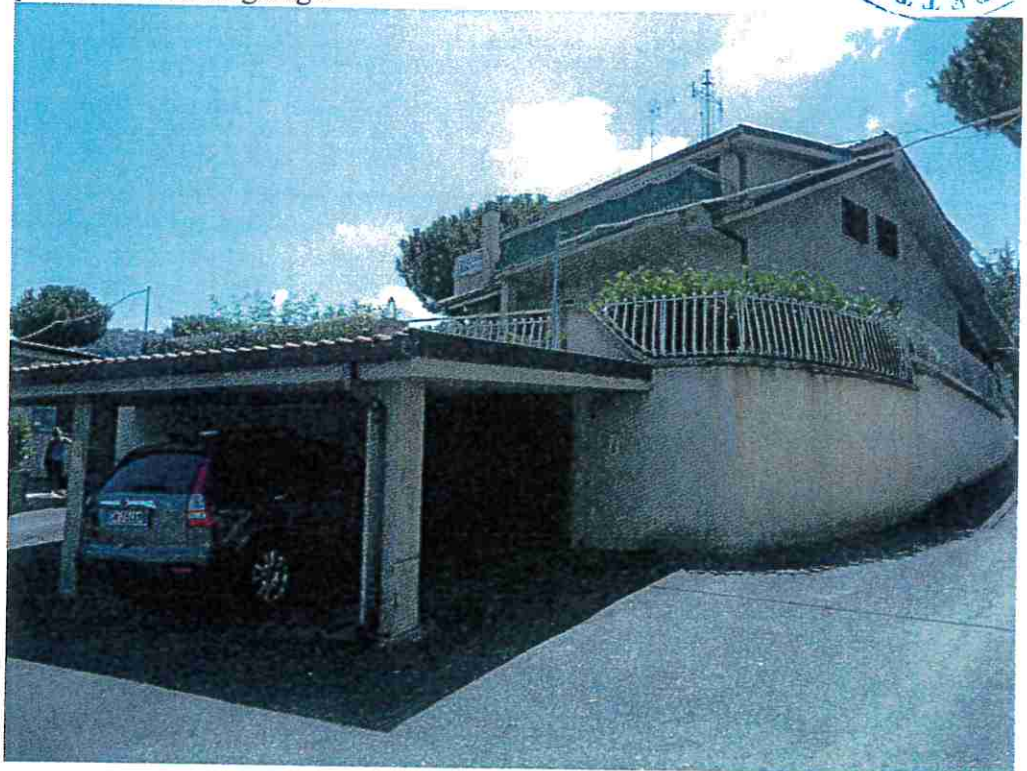
FOTO N°20: Villino, part.679 sub502(ex501), vista nord-est con portico e accesso garage:
