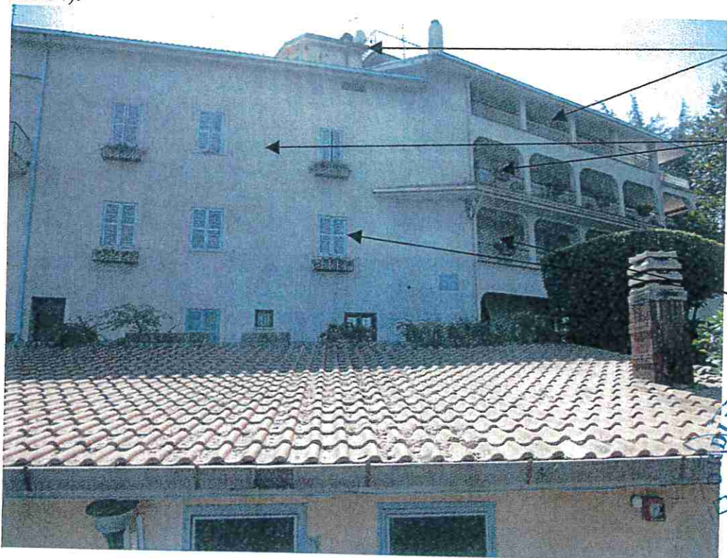
FOTO N°48: Appartamento part.686 sub507, piano 1°-2°3°, lato ovest(visto dalla part.1054, ex684):
