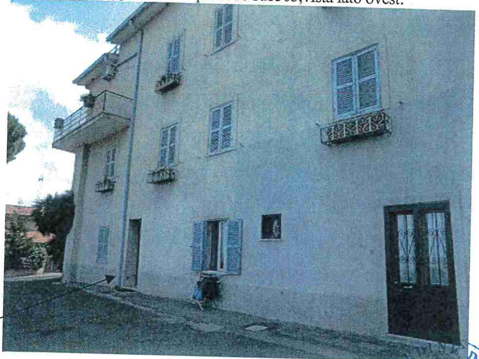
FOTO N°35: Appartamento part.686 sub505,vista lato ovest:
