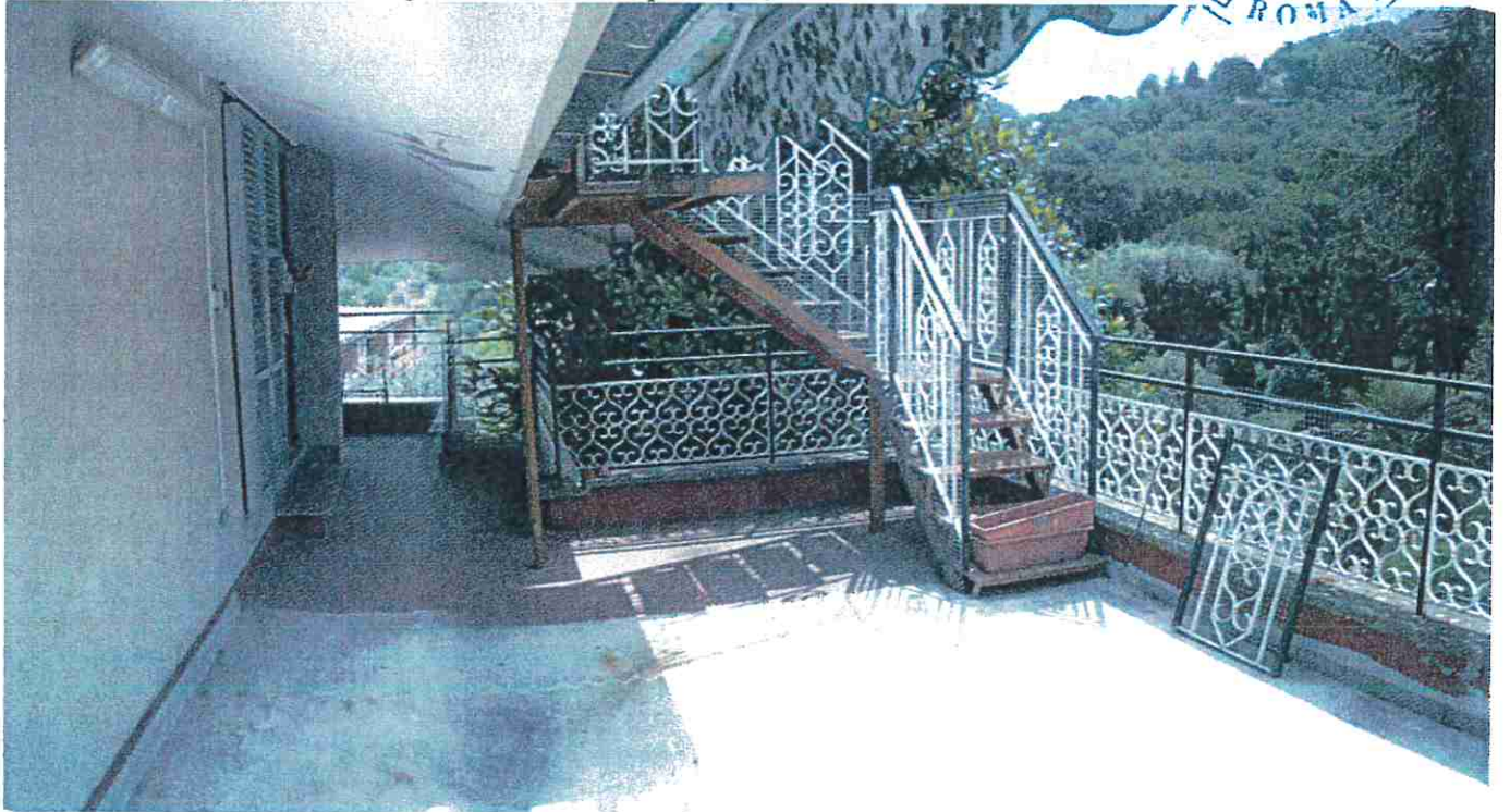
FOTO N°66: Appartamento part.686 sub507, piano 3°, terrazzo lato sud:
