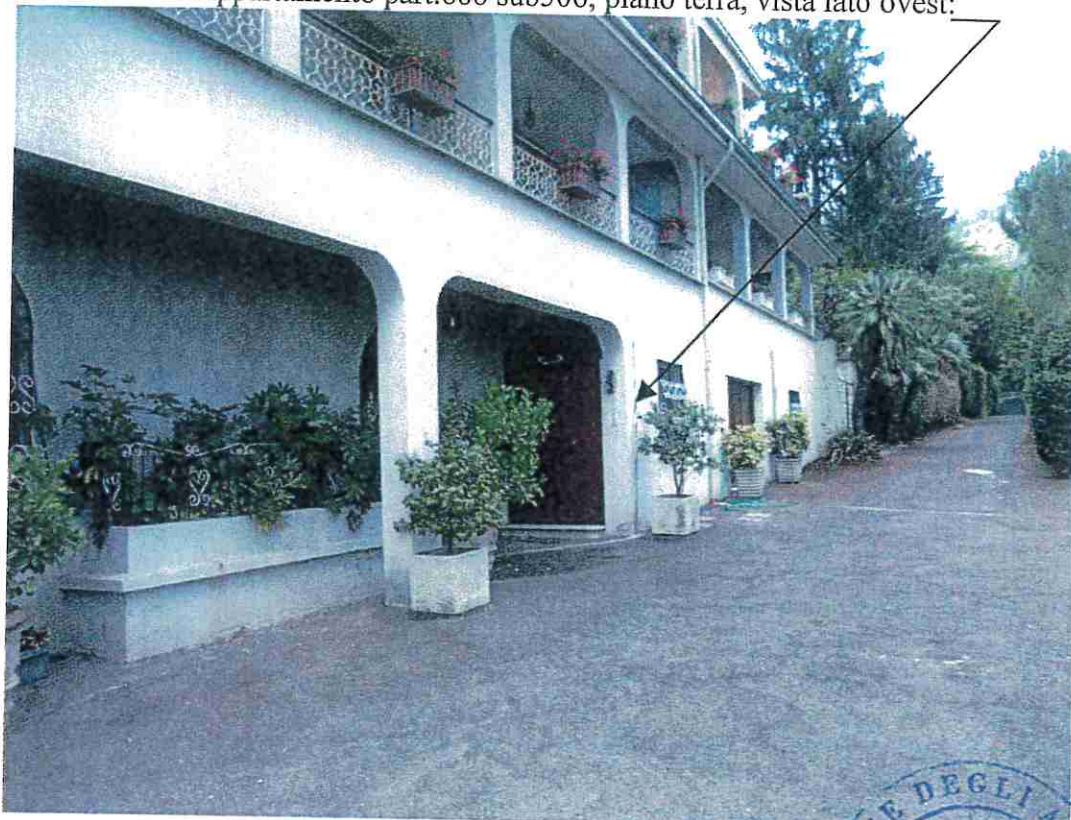
FOTO N°39: Appartamento part.686 sub506, piano terra, vista lato ovest:
