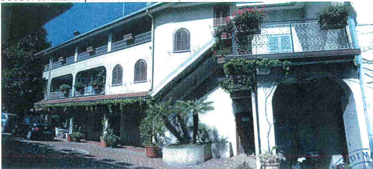
FOTO N°33: Edificio part.686 sub505-506-507,vista lato est:
